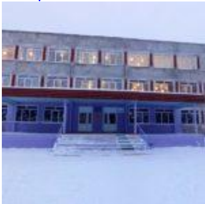
Точка роста. Фасад здания.
